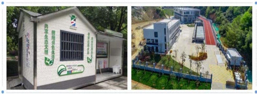
图 5 生活垃圾集置点建设
